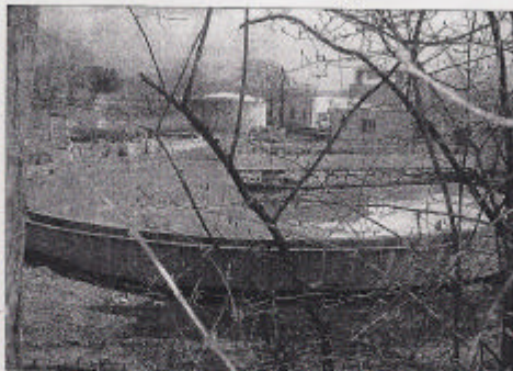
Deposito: i lavori di ampiamiento sono partiti assenti da Publacqua
